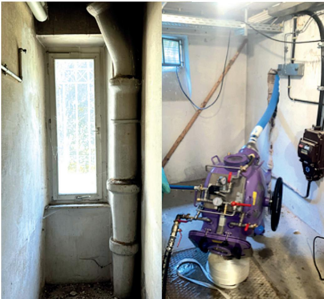
Durch den Einbau eines Inliners mit der kontrollierten Zugabe von Dampf erfolgt die Aushärtung noch schneller. So reduziert sich die Zeit in der Regel von ca. 24 Stunden auf ca. 12 Stunden einschließlich aller Vorbereitungen und Nebenarbeiten.
